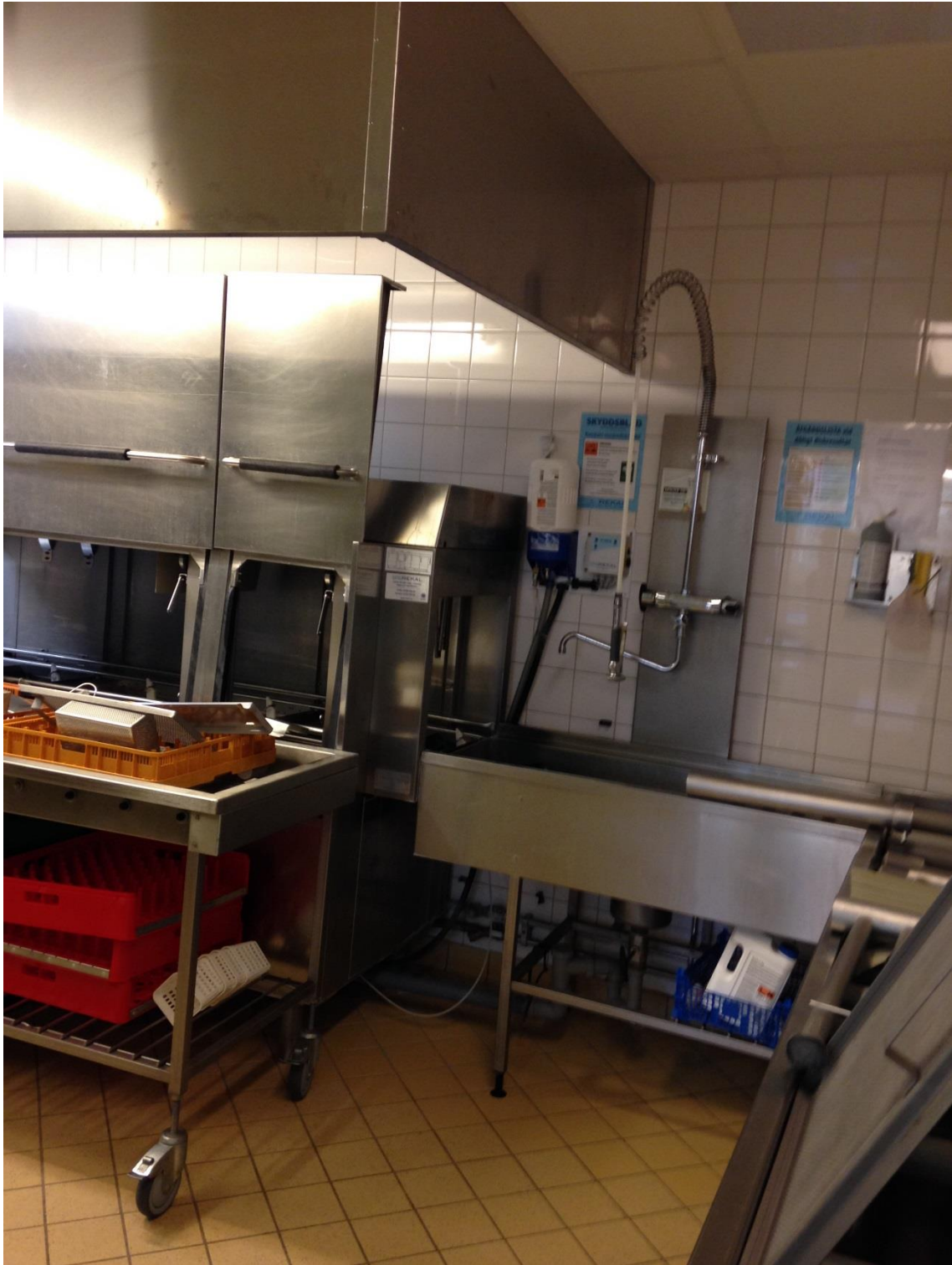
Bild 2. Diskmaskin med manuell försköljning med dusch.
