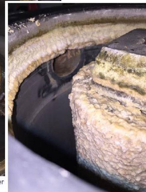
Bild 2: Fettansamling efter 5 månader i drift - Ytor för värmeväxling rena (automatisk rengöring)
