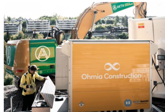
Elektrifiering av byggarbetsplatsen
